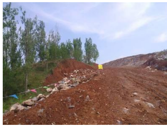
已建施工道路
