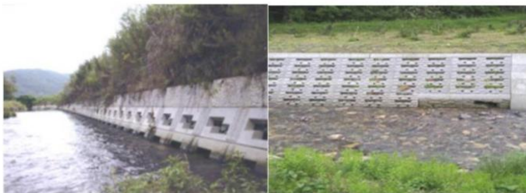
图 5-3 植草式生态挡墙实景照片
