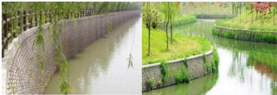
图 5-9 自嵌式拉筋挡土墙工程实例图
