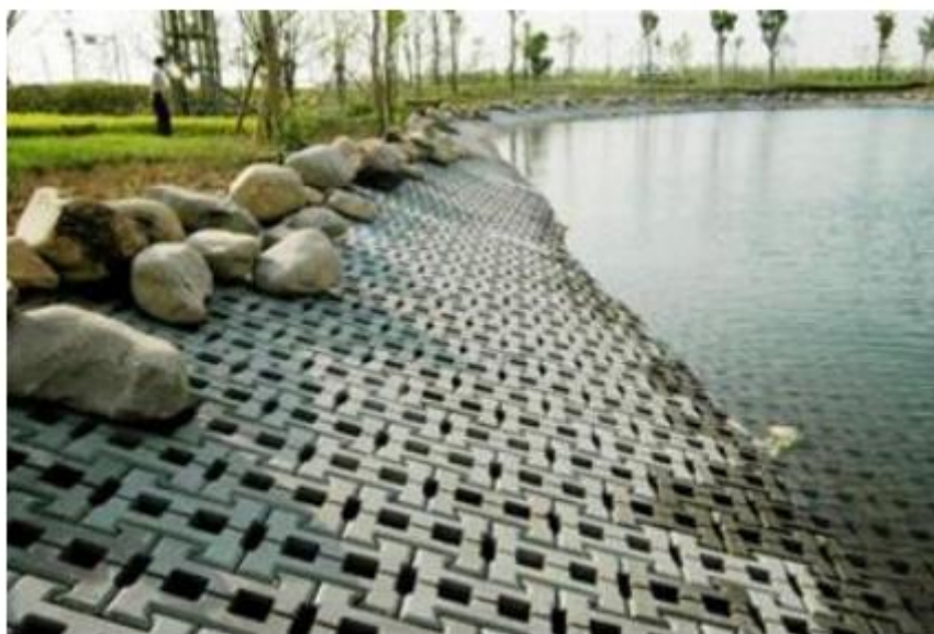
图 5-6 自锁式生态护坡实景照片
