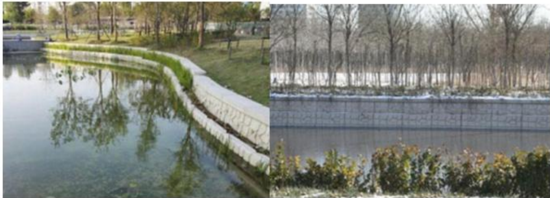
图 5-8 箱式阶梯连锁墙实景图
