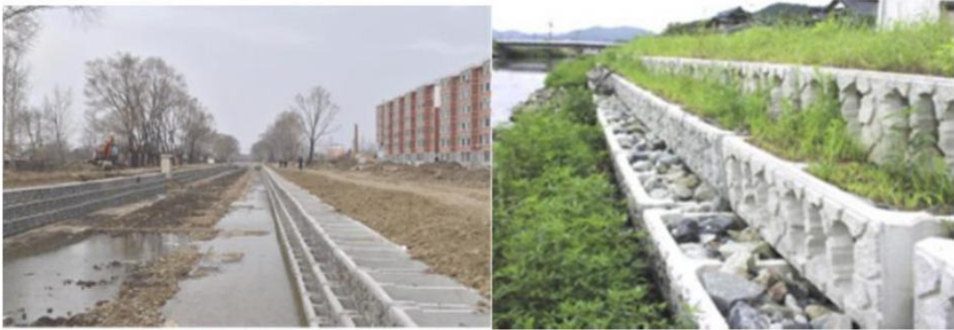
图 5-2 阶梯式生态挡墙实景照片
