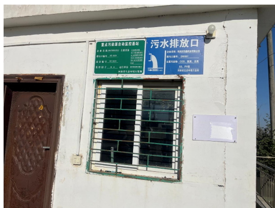
污水处理站总排口
