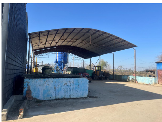
污泥暂存间（拟改造）
