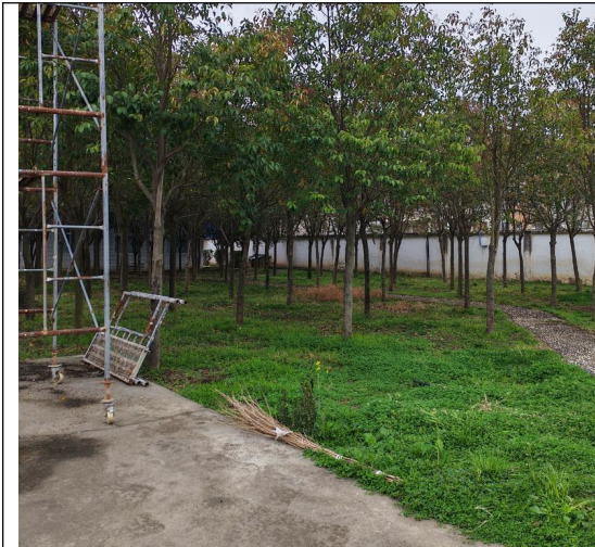
本次扩建工程位置现状
